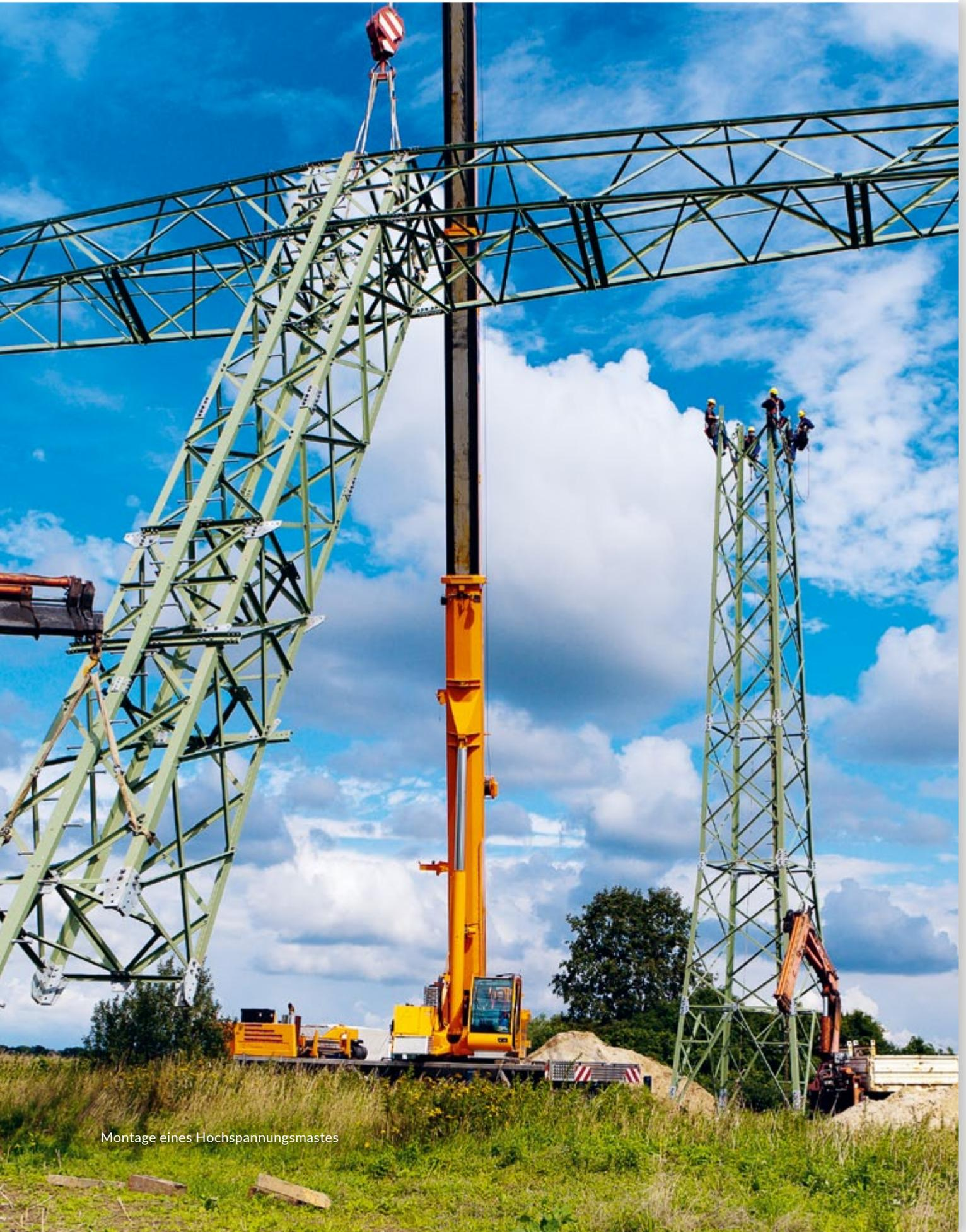
Montage eines Hochspannungsmastes
