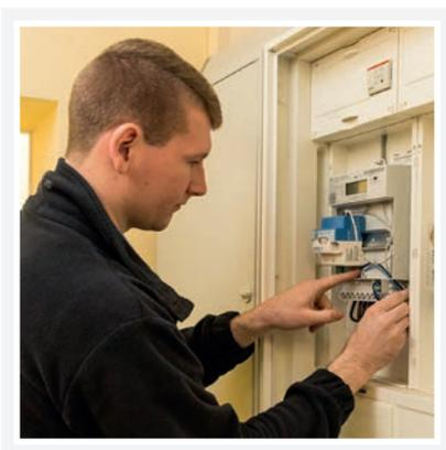
► Tobias Sass, Zählermonteur der e.dat GmbH, verbindet in der Kindertagesstätte Wittenförden das Smart-Meter-Gateway mit dem Zähler.
