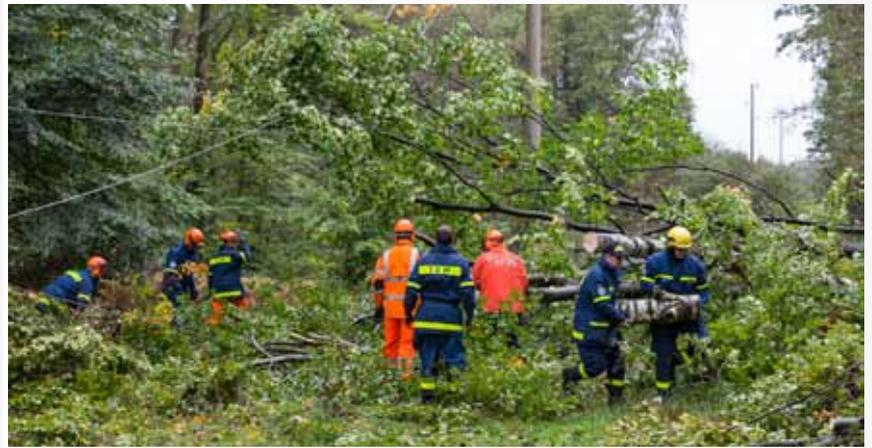
► Einsatzkräfte des Technischen Hilfswerks schneiden in Schildfeld bei Vellahn die Stromleitungen frei und stellen eine Zuwegung für die Hubbühne her, die für die Reparatur der 20-kV-Leitung gebraucht wird.
