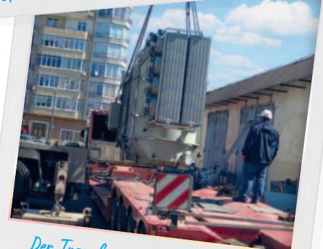
Aufladen des 110-kV-Transformators der WEMAG Netz GmbH bei Schwerin.
