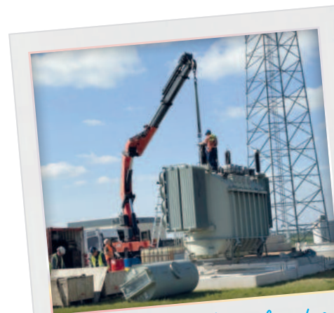
Aufladen des 110-kV-Transformators der WEMAG Netz GmbH bei Schwerin.
