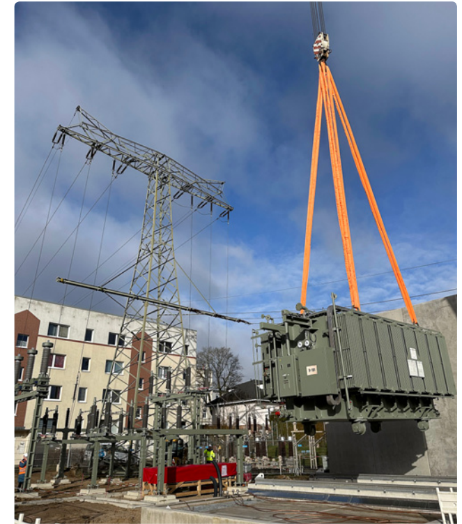
Millimeterarbeit: Der 110-kV-Transformator wird per Kran an seinen Bestimmungsort transportiert.
