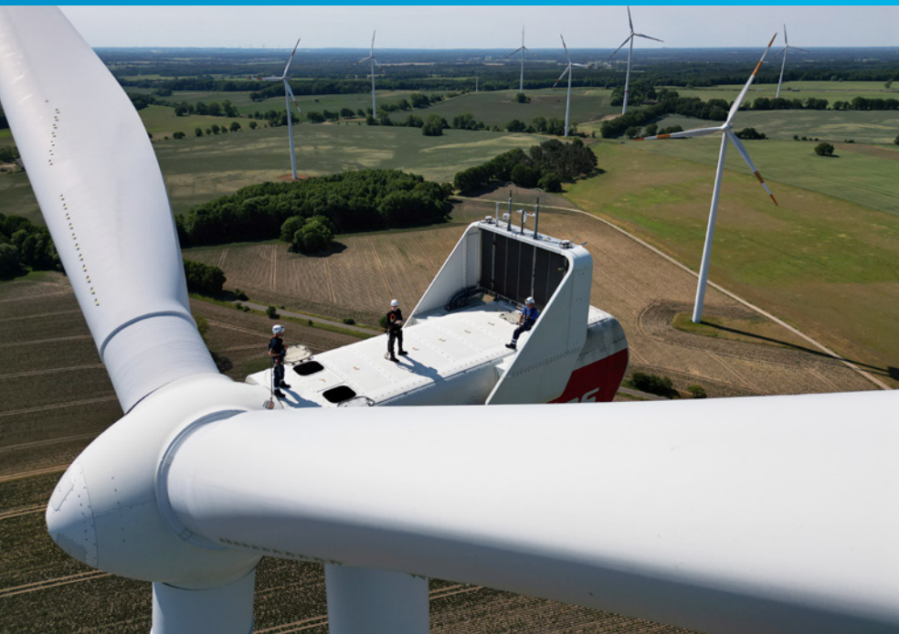
Ein ganz besonderer Ort zum Arbeiten: Wartungsarbeiten an einer Windkraftanlage
