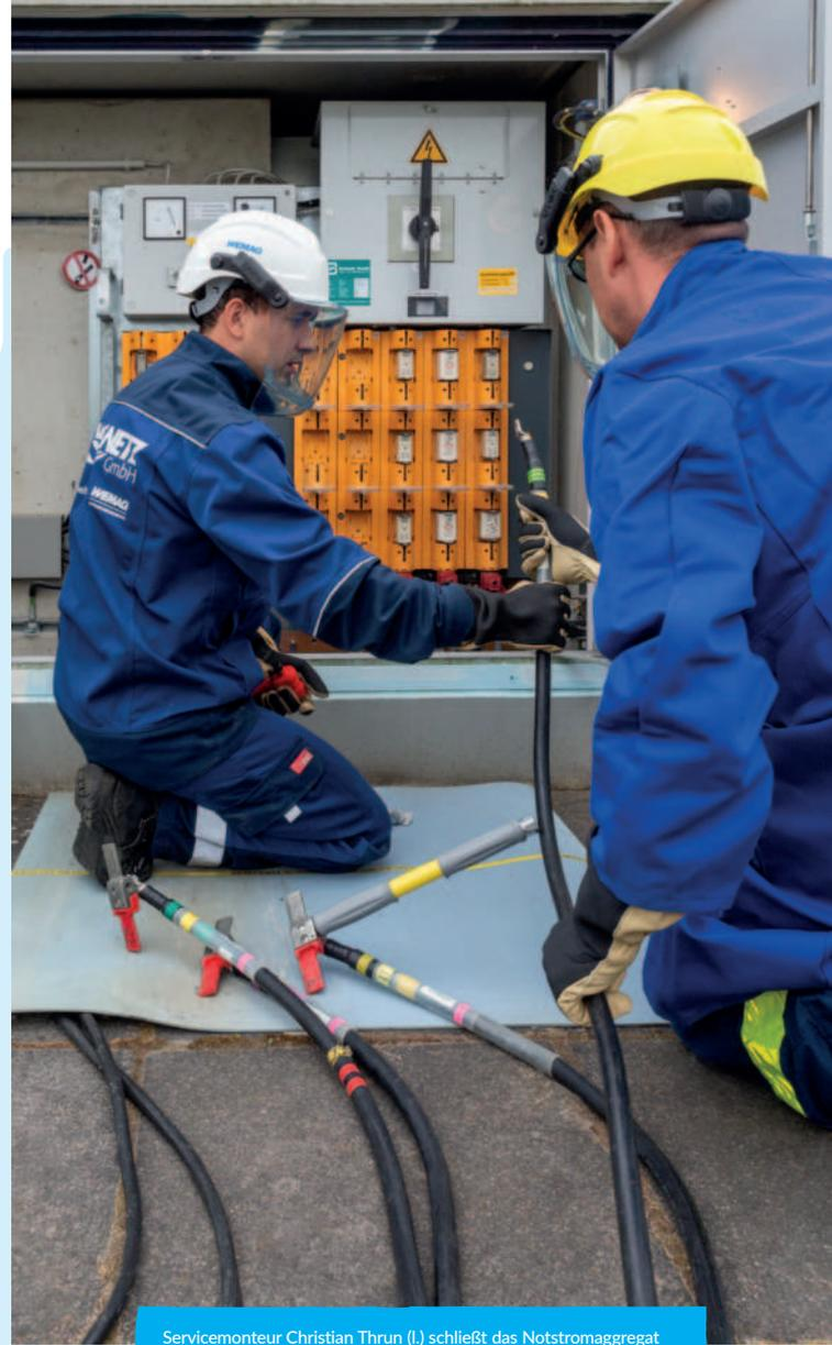
Servicemonteur Christian Thrun (l.) schließt das Notstromaggregat an die in Betrieb befindliche Transformatorstation der WEMAG Netz GmbH an. Thoralf Taft vom THW assistiert ihm dabei.
