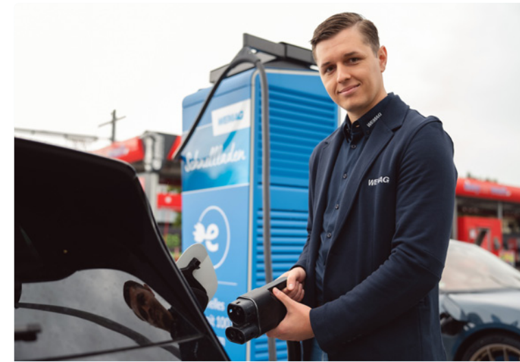
Elektrisch unterwegs mit den neuen Schnellladestationen der WEMAG
