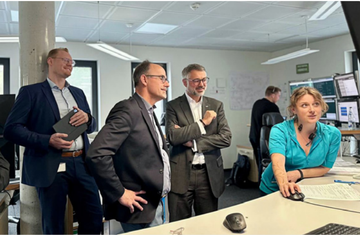
Mecklenburg-Vorpommerns Wirtschaftsminister Wolfgang Blank (2. v. l.) macht sich ein Bild von unserer Netzleitstelle, dem Herzstück der Versorgungssteuerung.
