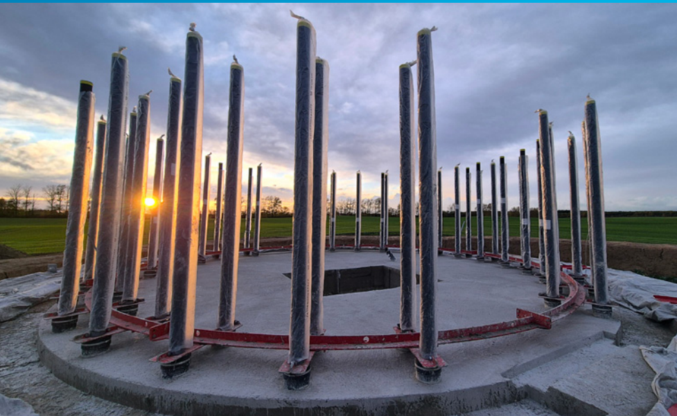
Stahlfundament einer Windenergieanlage zwischen Passow und Benthien
