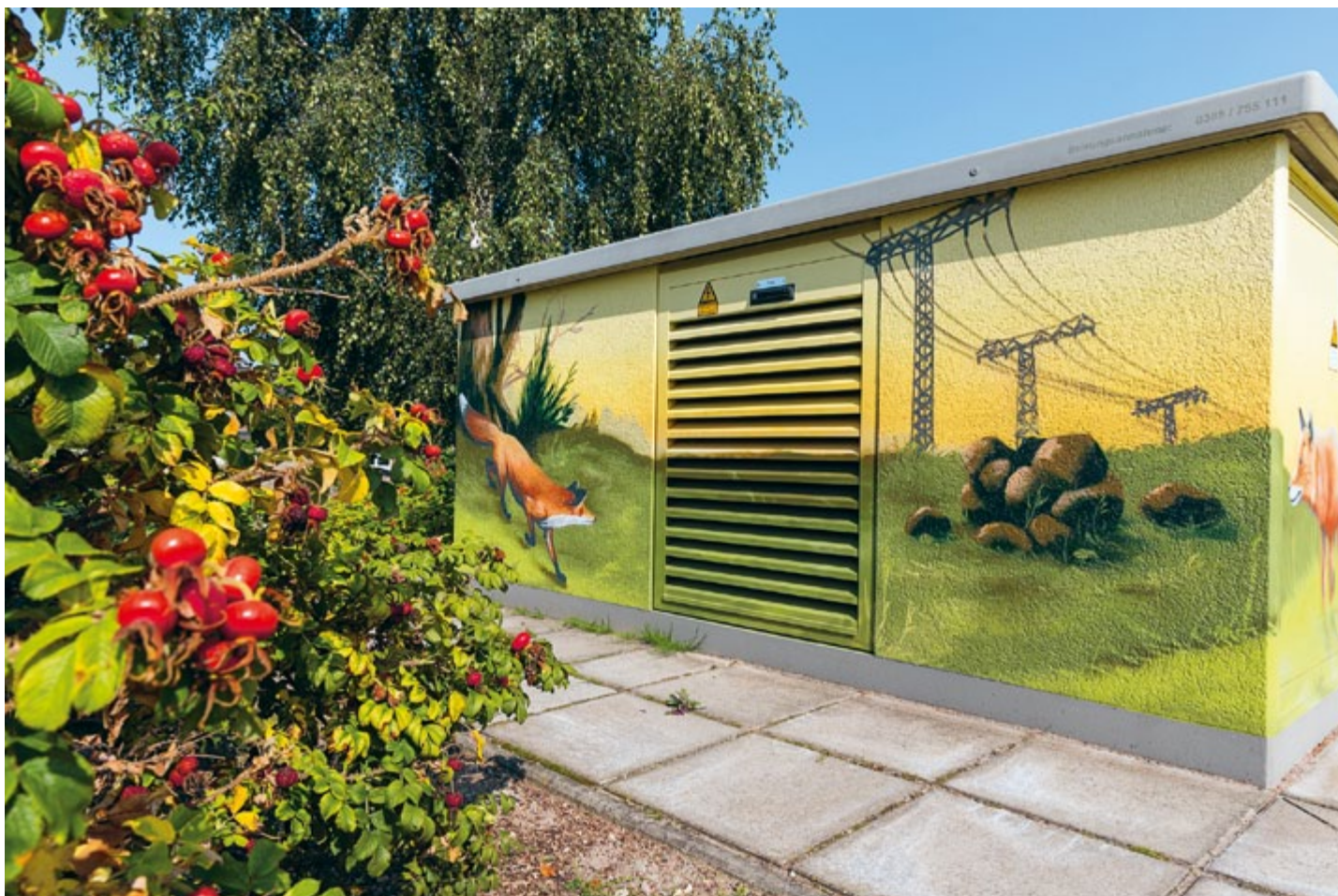
Transformatorenstation in Wittenförden bei Schwerin
