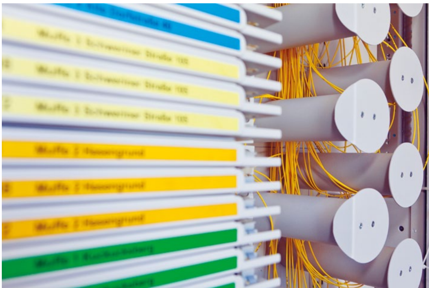
Glasfaserknotenpunkt der WEMACOM
