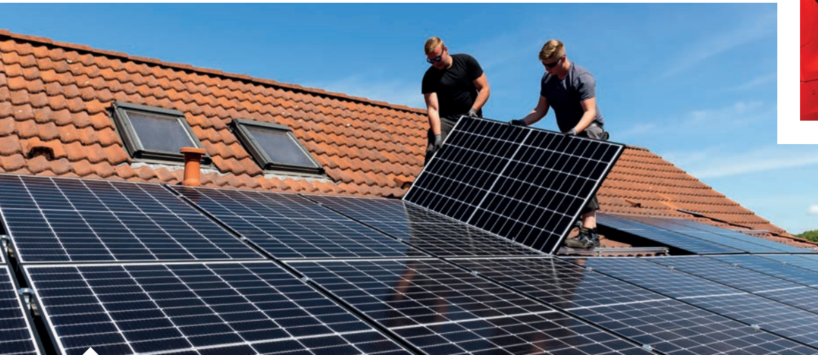
Auf dem Dach des Restaurants Mueßer Hof montieren Fachleute die Photovoltaikanlage.
